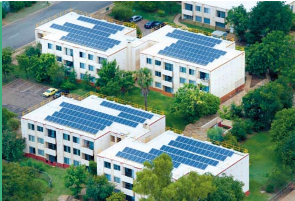
Paneles solares instalados en el complejo habitacional Parkside de Minas Mount Isa de Xstrata.
