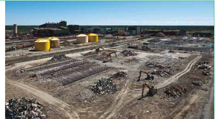
La operación metalúrgica Kidd ha desmantelado 36 edificaciones e infraestructura auxiliar en el contexto de su proyecto de recuperación.
